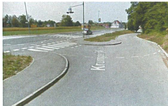
Slika 7: severni krak križišča KO1
